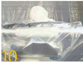
10 金属板を廃棄袋の底までそっと下ろし、もう一度湿潤剤で断熱材を湿らせます。断熱材が配管にしっかりと固定されている場合には、ワイヤーカッターを使って断熱材を切断してください。QTグローブバッグには独自の形状の廃棄袋が採用されており、配管断熱材を傷つけずに丸ごと簡単に除去できます。又配管に付着している断熱材の破片等も安全に除去することができます。
