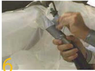
6 噴霧器に入れる湿潤剤の混合と使用に際しては、湿潤剤メーカーの指示に従ってください。エントリーポート（挿入口）からHEPA掃除機と噴霧器のホースを挿入し、ダクトテープを使ってそれぞれをエントリーポート（挿入口）上で密封します。
