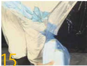
15 空気を十分に吸い取ったら、除去作業を終了した配管の真下にある汚れた作業エリアと、除去されたアスベスト断熱材が入っている廃棄物エリアの間を単純に捻じり、その捻じった部分をダクトテープでしっかりと巻きつけて密封します。
