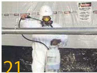
21 すべてのグローブバッグの作業エリアのポリシートを取り除いてアスベスト処理袋に入れて密封したら、断熱材を除去した後の全体の配管を抑制剤で固着させてしまいます。
