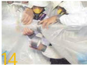
14 次に、除去作業が終わった配管とまだ汚染されている配管の作業エリアの間をダクトテープを使って密封してしまいます。ダクトテープを使って、配管の断熱材の除去作業が終わった部分とまだ終わっていない部分の間をしっかりと巻きつけて包んでください。HEPA掃除機を起動させ、グローブバッグ内の空気を抜きます。
