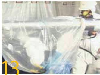
13 抑制剤をポンブスプレー器に入れ、配管の表面とグローブバッグの内部に十分に噴霧します。これで残っているアスベスト繊維の残りかすを固めて廃棄袋エリアに落とします。次に工具を隣の作業エリアの工具袋に移動させてください。
