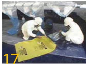
17 除去作業後のアスベスト廃棄物が入っている廃棄袋は、直ちに適切な表示が印刷されたアスベスト処理袋に入れます。これで次の作業エリアに進むことができます。同じ作業を繰り返してください。QTグローブバッグの廃棄袋エリアのデザインは初期のグローブバッグの設計を大幅に改善したのようになってきました。初期のデザインは廃棄袋エリアが作業エリアと同じ幅で広すぎたため、15)で行うべきねじってダクトテープを巻きつける、この重要なプロセスが実施しにくくなっていました。
