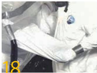
18 QT連続式グローブバッグの最後の作業エリアでの作業が終了したら、必ず工具を取り出してください。作業エリアの付いているゴム手袋で工具をつかみ、つかんだまま手をひっぱり出して袖を裏返します。ゴム手袋上の袖部分を捻じり、その部分をダクトテープでしっかりと包んで、テープが貼られた部分の中心部から切り離して処理剤の中につけてください。処理剤の中で適切な処理の後に工具を取り出してください。
