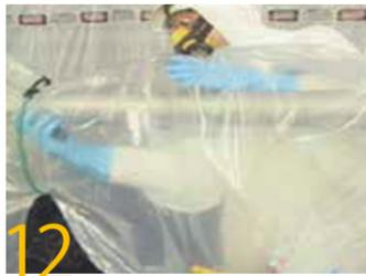
12 作業エリアと廃棄袋エリアが連続してつながっているQTグローブバッグの長所として長い配管や連続している配管の除去作業を連続的に処理できるという有利性があります。へらや金ブラシ等を使って、残っているアスベスト断熱材の破片やかけらが完全にかき出すか、削り取ってください。断熱材が完全に除去されたら、ブラシと湿潤剤を使って配管をきれいに洗浄します。
