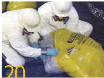
20 次に残った作業エリア部分を順次配管から除去します。作業エリアの上部にかッターで切り込みを入れ内側に折り曲げながら、適切な表示が印刷されているアスベスト処理袋に入れます。
