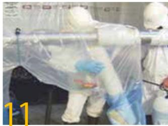
11 断熱材を配管からはがして、廃棄袋の底まで下ろします。断熱材が隣の作業エリア付近まで延びている場合には、これも必ず取り除いてください。通常、断熱材は半円形で配管に取り付けられています。断熱材は、3フィートか1メートル単位で使用されることが多いため、注意深く継ぎ目を探せば、断熱材を傷つけずに簡単に除去することができます。断熱材が非常に劣化していたり、もろくなったりしていない限り、これらの部分は、通常簡単に取り除くことができます。
