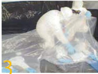
3 除去作業する配管断熱材の長さに必要なグローブバッグを外箱から引っぱり出して広げます。作業対象の配管の外径より少し大きめの作業エリアを持つグローブバッグを使うと、簡単に作業する配管の外径に装着できます。作業配管の長さが決まったら、必要な長さにかッターナイフを使って廃棄袋を分離してください。グローブバッグに印が付いている部分（マジックで印が付いています。）でグローブバッグを切り離します。作業を始める前にグローブバッグの作業エリア内の工具袋に必要な工具を入れてください。このQTグローブバッグには、連続して作業エリアと廃棄袋がつながっているため複数のグローブバッグを同時に利用できるといふ長所があります。同じ作業を何度も行う必要がないため、セットアップ時間が短縮されるのです。従来型の養生シートを使ってセットアップすると複数の小さなバッグをセットアップするのとでは、労務費が最大で40%も違ってきます。
