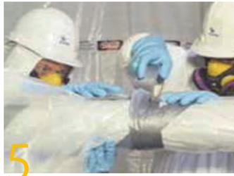
5 作業配管の端の部分に戻り、配管周囲で開いている作業エリアのポリシートをまとめ、ダクトテープを何重にも巻いて配管上でしっかりと密封します。作業配管の反対側の端の部分についても、この手順を繰り返してください。最大作業エリアに合わせて両端部を取り付けますが、その際、ややたるみを持たせるようにします。このたるみ、範囲内にある作業エリア内での作業を容易にしたグローブバッグの廃棄袋を取り外したりする際になります。配管固定器具がある場合には、カッターナイフで慎重に切り取り、ダクトテープで密封してグローブバッグを取り付けてください。適切な長さのダクトテープを各作業エリアの間を軽く支えます。連続しているグローブバッグの隣の作業エリアへ通る断熱材にアクセスできるだけの余裕を確保してください。
