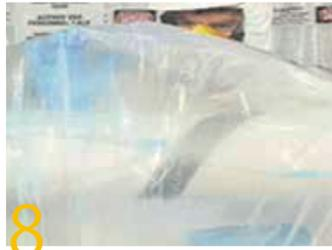
8 煙が漏れている部分があれば、新たにダクトテープで密封し直し、最初の作業エリアを締めます。グローブバッグ内で作業を開始する前に、各グローブバッグの作業エリアにおいて、この手順を繰り返します。アスベスト除去作業中に、グローブバッグに穴があいた時には、直ちにダクトテープで補修して密封状態にもどしてください。
