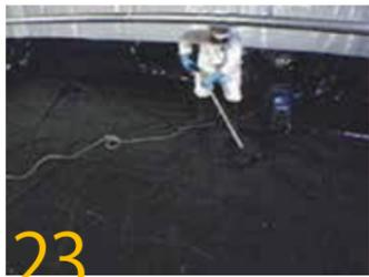
23 最後の掃除のためにエリアに掃除機をかけ、清掃して作業を終了します。装着していた作業着等を規則に従って適切に処分してください。最後に、作業現場を表示するテープと警告表示を撤去します。お疲れ様でした。これでグローブバッグでの除去作業は完了です。
