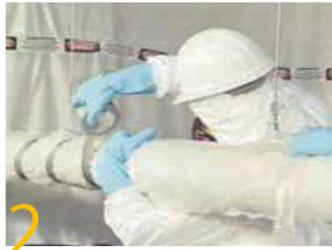
2 断熱材がもろく、砕けやすい場合には、除去作業の期間中、作業対象となる配管及び作業エリアに隣接する配管をポリエチレンシートで包んでください。さらに上記写真のように包んだポリシートをダクトテープでラセン状にテーピングして固定してください。これによりアスベスト繊維の飛散を防止します。次に除去作業の対象となる配管の長さを測定します。必要な長さのグローブバッグをロールから切り取る時のサイズおよび廃棄袋の数については、このカタログの裏面の仕様書および図を参考にしてください。
