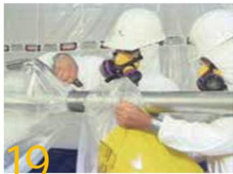
19 今まで説明した手順に従って最後のグローブバッグの最後の処理袋エリアを取り外します。
