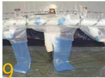
9 これで、断熱材除去作業の準備ができました。最初の作業範囲のグローブバッグの作業エリアに付いている袖部分に手と腕を入れ、湿潤剤で断熱材を十分に湿らせてください。断熱材を固定しているバンドやワイヤを金切りばさみで切ります。断熱材に金属製のカバーが付いている場合には、特に慎重に金属カバーを取り除いてください。金属板の先端がとがっている、グローブバッグが切れるおそれがあります。金属板の先端を内側に折り曲げ、先端の尖った部分が露出しないようにしてください。先に別の土嚢袋等を準備して金属板を処理して、グローブバッグを保護する業者もあります。
