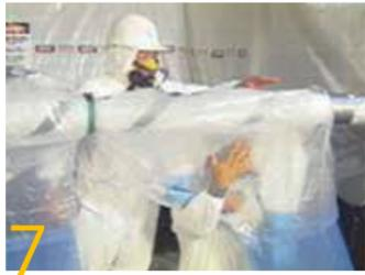
7 次に、煙試験キットを使って、グローブバッグがきちんとテープシールされ密封されているかどうかを試験します。まず、紐かダクトテープを使って最初の作業範囲内のグローブバッグの作業エリアをしっかりと締めます。任意のエントリーポートから発煙器を挿入し、ちょうど作業エリアに充滿する程度の煙を発生させた後、発煙器を取り出し、ダクトテープでエントリーポートを密封します。バッグを優しく握り、煙がテープシール部分から漏れるかどうかを観察します。
