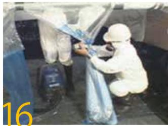
16 HEPA掃除機を起動させながら湿潤剤噴霧器のホースを取り外し、ダクトテープでホースを取り外した後のポートの穴を密封します。掃除機を止め、作業エリアと廃棄物エリアの間でねじってダクトテープで巻きつけられた部分の真ん中で、廃棄袋を作業エリアから切り離します。巻きつけられたダクトテープの中心を切り開くと、シールの機密性能を損なうことなく、アスベスト繊維の飛散を防ぐことができます。次に、グローブバッグの作業エリアから掃除機のホースを取り出し、ダクトテープで再度、ポートを密封します。
