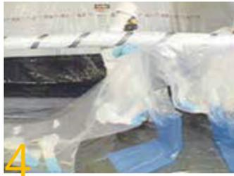
4 次に、グローブバッグを取り付けます。グローブバッグの作業エリア部分の上部両端を持ち、配管の所に持って行ってください。廃棄袋エリアと一緒に移動し、配管の周囲で開口部を引っ張り張ります。無理に引っ張らないようにして、上部両端を重ね合わせてください。ダクトテープを少し取り、バッグを所定の位置に留めます。グローブバッグの各作業エリアのポリシートの端を順次平らにし、ダクトテープを使って、バッグ開口部を端から端まで密封します。この時、ダクトテープが配管断熱材に触れないようにしてください。配管固定器具がある部分の開口部は、そのままにしておきます。
