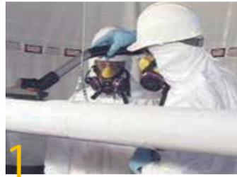
1 アスベストを含有している断熱材の状態を調べ、除去作業中に配管断熱材の損傷部分からアスベスト繊維が飛散するおそれがないことを確認してください。断熱材がすでに損傷を受けている場合には、除去作業を開始する前に粉じん抑制剤等で損傷部分を処理する必要があります。HEPA真空掃除機で慎重に配管を掃除し、すべてのアスベストダストを除去します。除去作業の対象となる配管と、それに隣接する配管のうち、作業者が接触するおそれがあったり、除去作業中の振動の影響を受けたりする可能性がある配管を掃除してください。
