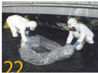
22 グローブバッグの最後の作業エリアのシートが取り除かれ、安全に処分されたら、清掃と浄化を開始してください。作業場の床に敷いていたポリシートを内側に折り、アスベスト処理袋に入れます。除去作業中に落ちた全ての物がこぼれ出たりしないように細心の注意をしてください。すべてのアスベスト処理袋を密封し、すべての規則に適合する方法で廃棄します。特別に浄化ユニットが設備されている場合には、その現場の適用されるすべての手順に従ってください。
